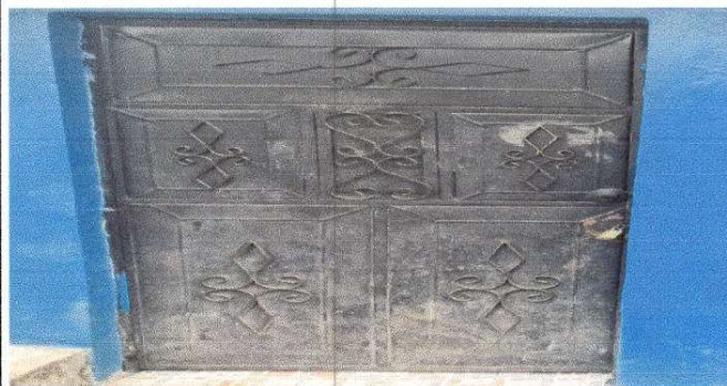
Foto 2: Sustrución de puerta en servicio sanitario
