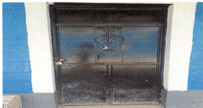
Foto 1: Sustrución de chapa
