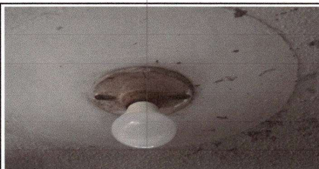
Foto 6: Sustrución de focos ahorradores
