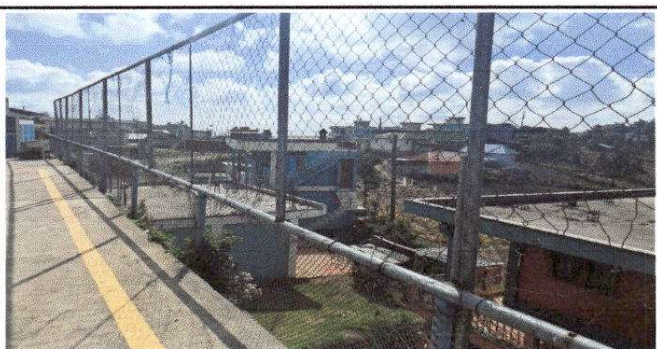
Foto 5: Reparación de tubo hg y malla galvanizada
