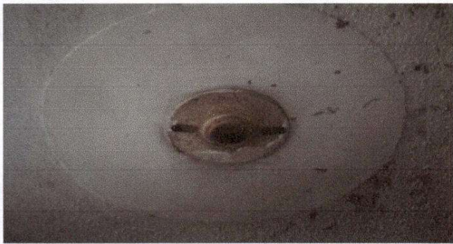
Foto 7: Sustitución de plafoneras
